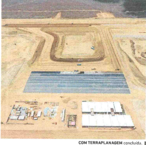
COM TERRAPLANAGEM concluída, pista começa a ser pavimentada
